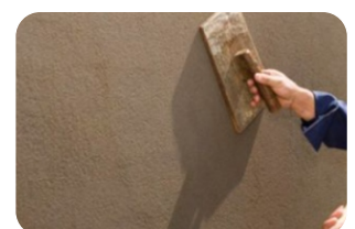
Trát phủ tạo phẳng bề mặt bằng vữa xi măng trộn Revinex® hoặc Latex BS 8430
