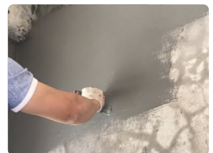
Trát phủ tạo phẳng bề mặt bằng vữa xi măng trộn Revinex® hoặc Latex BS 8430
