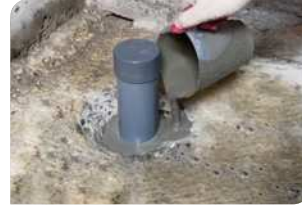
Thi công đổ vữa Lemax Grout LM-G650
