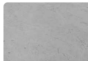
Bề mặt bê tông đạt
