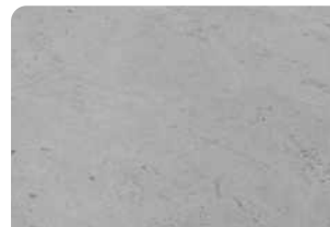
Bề mặt bê tông đạt
