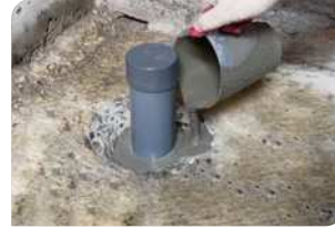
Thi công đổ vữa Lemax Grout LM-G650
