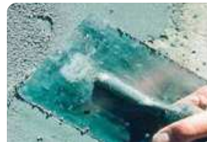
Trám và bề mặt bê tông bằng vữa sửa chữa Neorep
