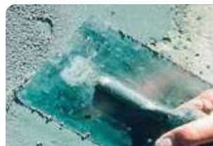
Trám và bề mặt bê tông bằng vữa sửa chữa Neorep
