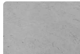
Bề mặt bê tông đạt
