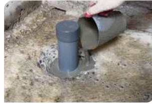
Thi công đổ vữa Lemax Grout LM-G650
