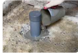
Thi công đổ vữa Lemax Grout LM-G650
