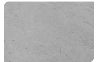
Bề mặt bê tông đạt
