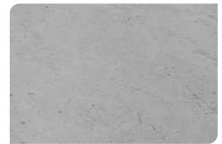
Bề mặt bê tông đạt
