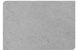
Bề mặt bê tông đạt
