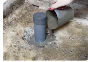
Thi công đổ vữa Lemax Grout LM-G650
