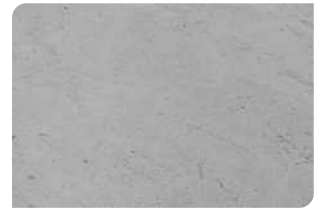
Bề mặt bê tông đạt
