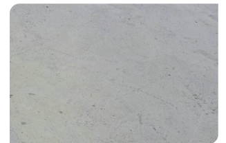
Bề mặt bê tông đạt
