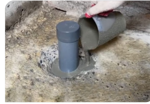
Thi công đổ vữa Lemax Grout LM-G650
