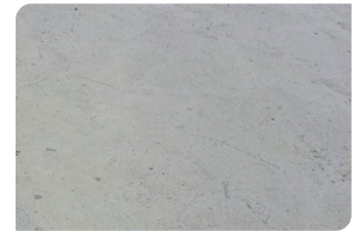
Bề mặt bê tông đạt
