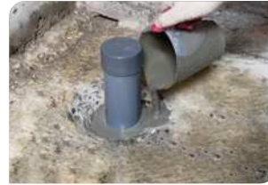
Thi công đổ vữa Lemax Grout LM-G650
