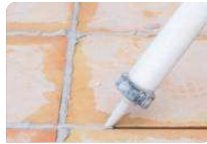
Trám vá mạch gạch bằng keo trám khe BS 8620S/ Jointex®
