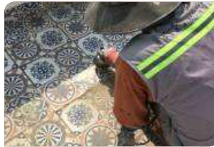
Sử dụng máy mài chà bề mặt gạch men
