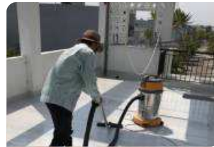
Vệ sinh, trám và mạch gạch bằng keo trám khe BS 8620S/ Jointex®
