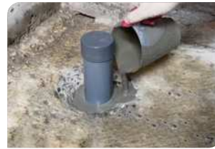
Thi công đổ vữa Lemax Grout LM-G650
