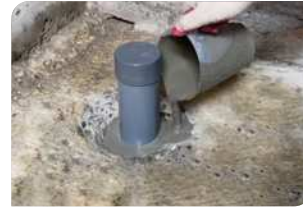
Thi công đổ vữa Lemax Grout LM-G650
