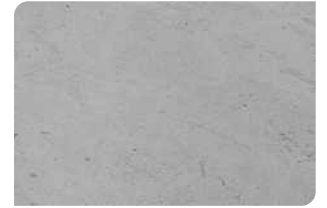
Bề mặt bê tông đạt
