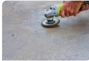
Sử dụng máy mài chà bề mặt bê tông
