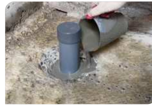
Thi công đổ vữa Lemax Grout LM-G650
