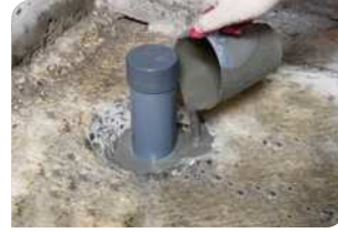
Thi công đổ vữa Lemax Grout LM-G650
