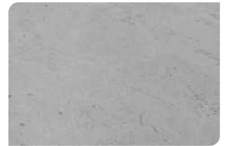
Bề mặt bê tông đạt
