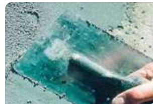
Trám vá bề mặt bê tông bằng vữa sửa chữa Neoprep
