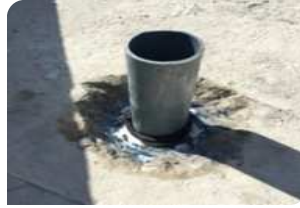
Vệ sinh cổ ống, quét thành trường nở
