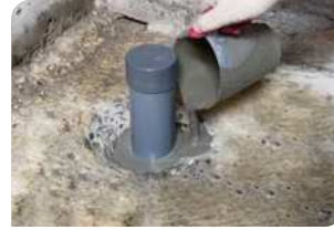
Thi công đổ vữa Lemax Grout LM-G650
