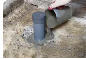
Thi công đổ vữa Lemax Grout LM-G650
