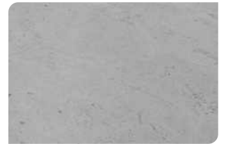
Bề mặt bê tông đạt
