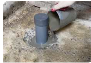
Thi công đổ vữa Lemax Grout LM-G650
