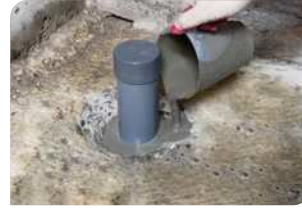
Thi công đổ vữa Lemax Grout LM-G650
