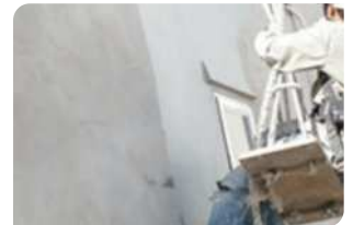
Bề mặt bê tông đạt
