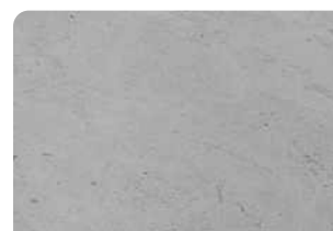
Bề mặt bê tông đạt
