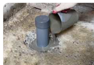
Thi công đổ vữa Lemax Grout LM-G650
