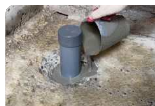
Thi công đổ vữa Lemax Grout LM-G650
