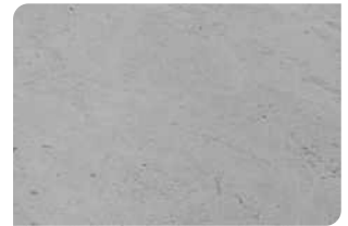
Bề mặt bê tông đạt
