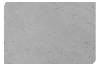
Bề mặt bê tông đạt
