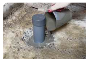
Thi công đổ vữa Lemax Grout LM-G650
