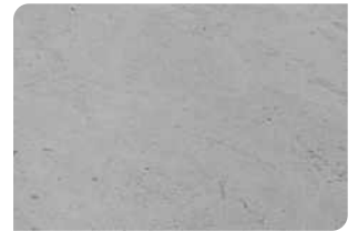
Bề mặt bê tông đạt
