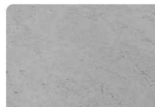
Bề mặt bê tông đạt
