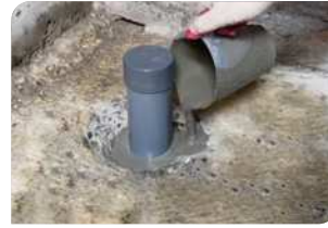
Thi công đổ vữa Lemax Grout LM-G650
