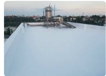
Bước 6: Bề mặt hoàn thiện (vật liệu đóng cứng hoàn toàn sau 7 ngày), sau đó ngâm nước nghiệm thu công trình.
