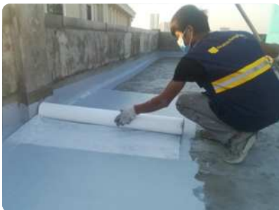
Bước 4: Gia cố vải Neotextile góc chân tường và toàn sàn trong khi lớp phủ thứ nhất còn ướt để gia cường chống chịu.
