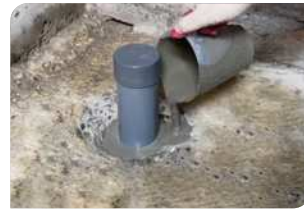
Thi công đổ vữa Lemax Grout LM-G650
