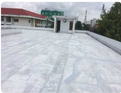
Bước 1: Vệ sinh bề mặt bê tông trước khi thi công
