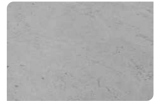
Bề mặt bê tông đạt
