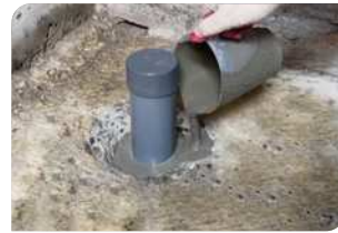
Thi công đổ vữa Lemax Grout LM-G650
