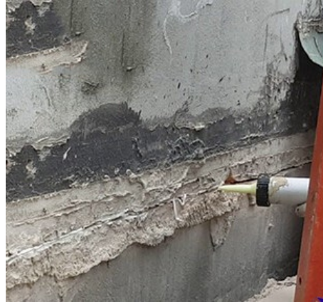
Fill Neotex® PU Joint
