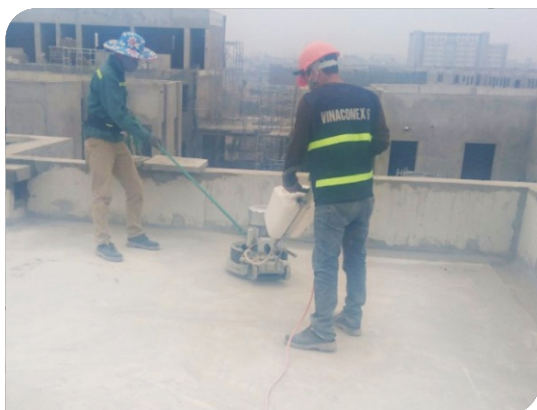
Vệ sinh chuẩn bị bề mặt
