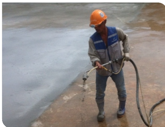
Thi công lớp thứ nhất
