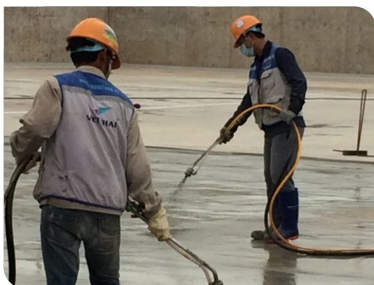
Thi công lớp thứ hai
