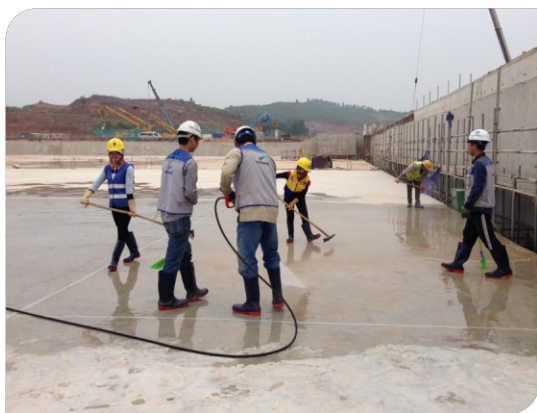
Vệ sinh chuẩn bị bề mặt
