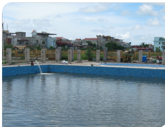
Bơm nước nghiệm thu công trình
