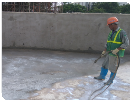
Thi công bằng máy phun
