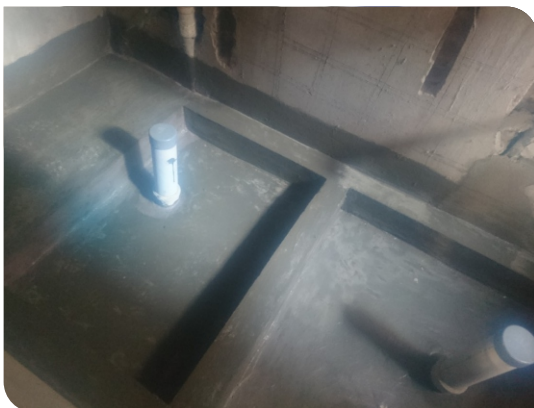
Thi công lớp thứ hai
