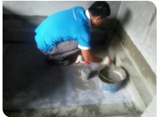
Thi công lớp thứ nhất
