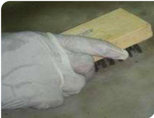
Vệ sinh bề mặt
