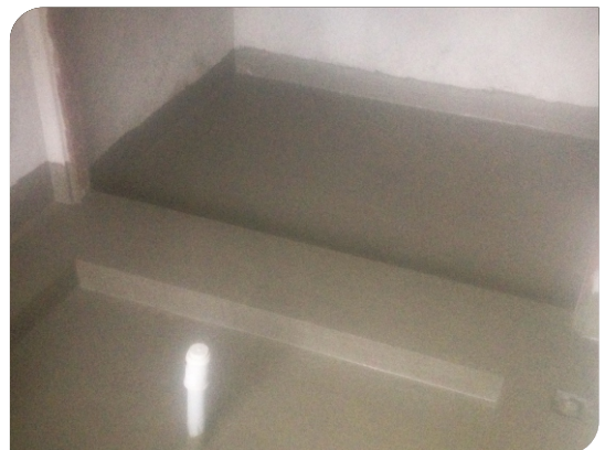
Bề mặt hoàn thiện
