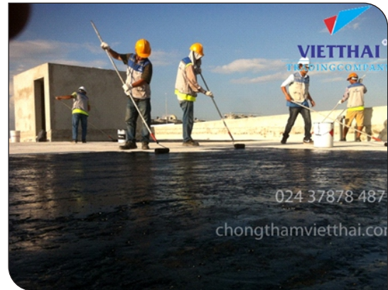
Thi công lăn lớp lót
