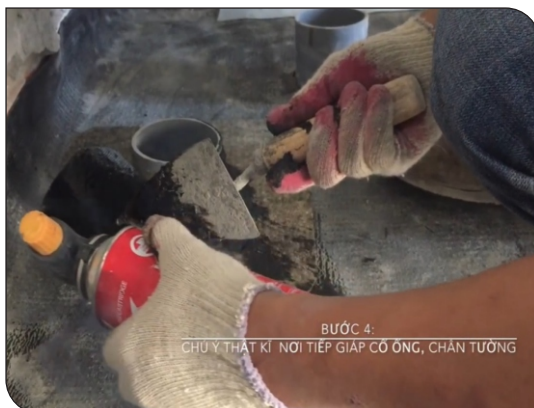
Xử lý cổ ống thoát nước
