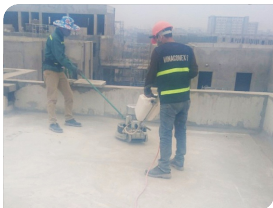
Vệ sinh chuẩn bị bề mặt
