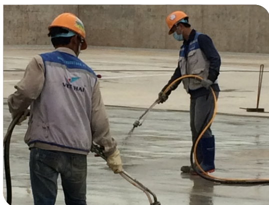
Thi công lớp thứ hai
