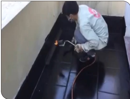
Xử lý góc chân tường
