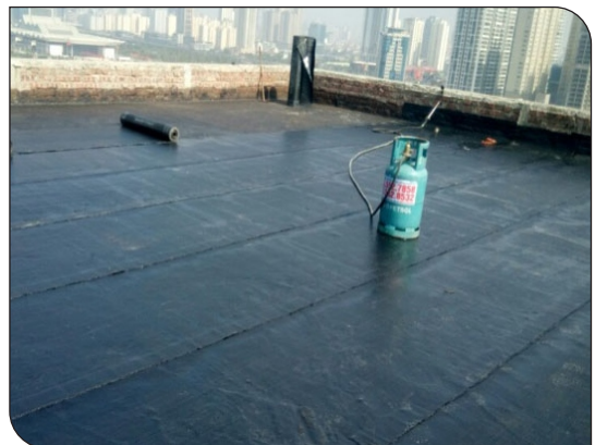
Bề mặt hoàn thiện
