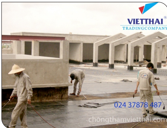
Thi công màng khô nóng
