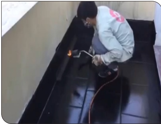
Xử lý góc chân tường
