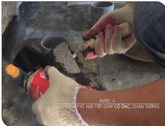
Xử lý cổ ống thoát nước
