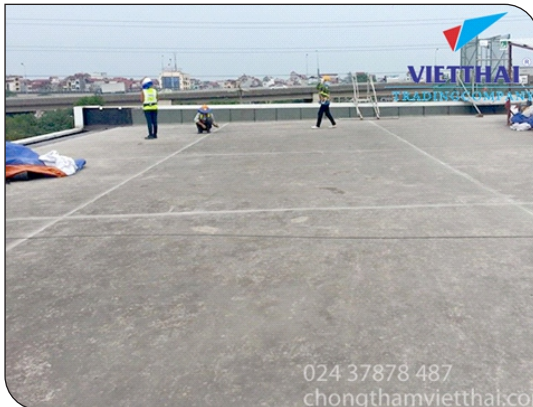
Chuẩn bị bề mặt
