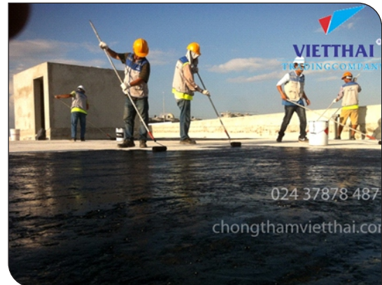
Thi công lăn lớp lót
